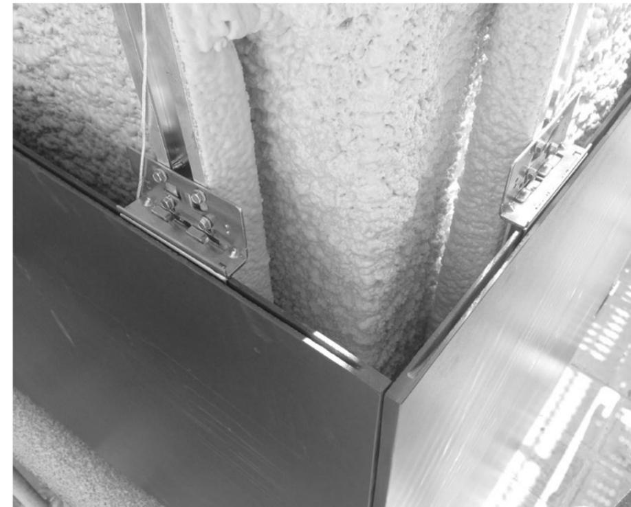
Este sistema suele contar con dos tipos diferentes de grapa: una simple de arranque y/o coronación y otra doble intermedia; que se fijan a la perfilería vertical mediante atornillado.
