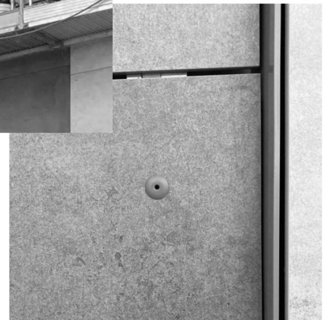
Fijación mecánica vista mediante remaches.
