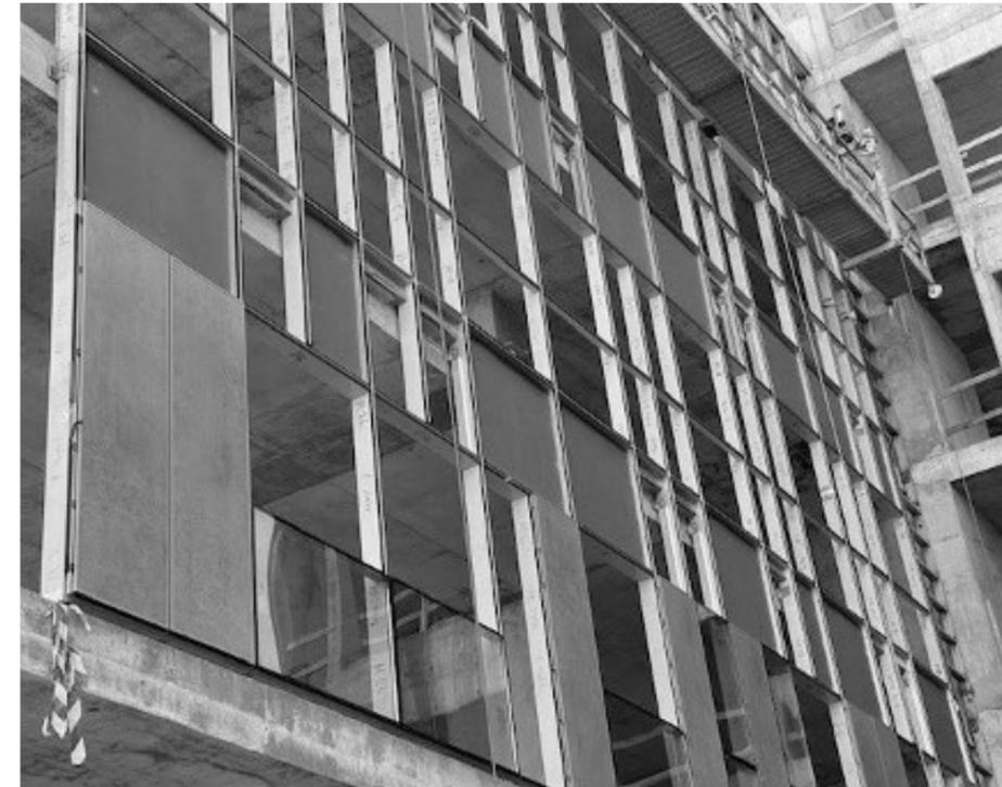
Los elementos de relleno se dividen entre los que son transparentes o traslucidos y aquellos opacos entre los que entraría Dekton, que puede fijarse a montantes y travesaños mediante diversos sistemas según el tipo de estructura y requerimiento de proyecto.
