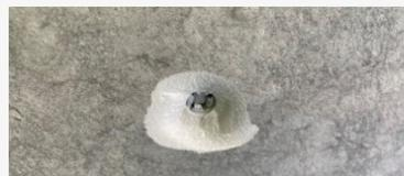
Imágenes con ejemplos de desconchamientos producidos por la penetración de agua en los taladros, combinados con temperaturas de congelación, que causan la rotura del producto.
