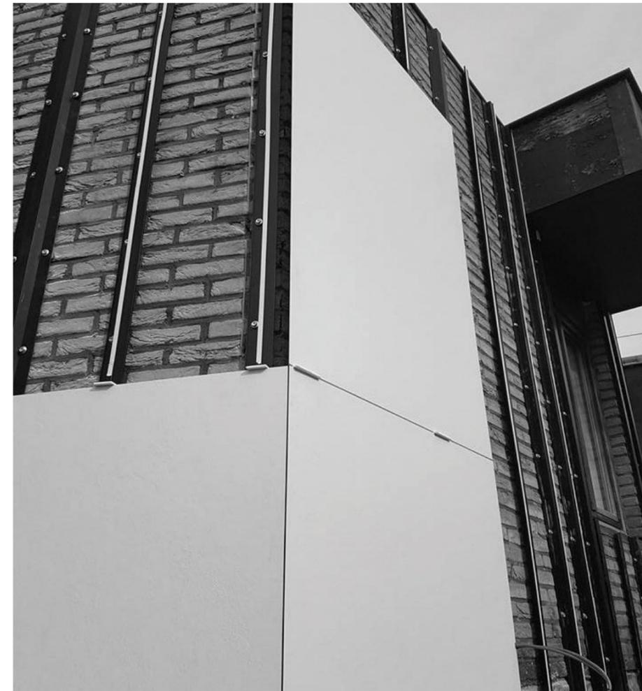
Fijación con anclaje químico sobre perfilera.
