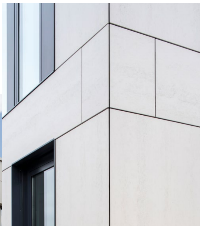
Edificio de oficinas Shittethelm (Alemania)
