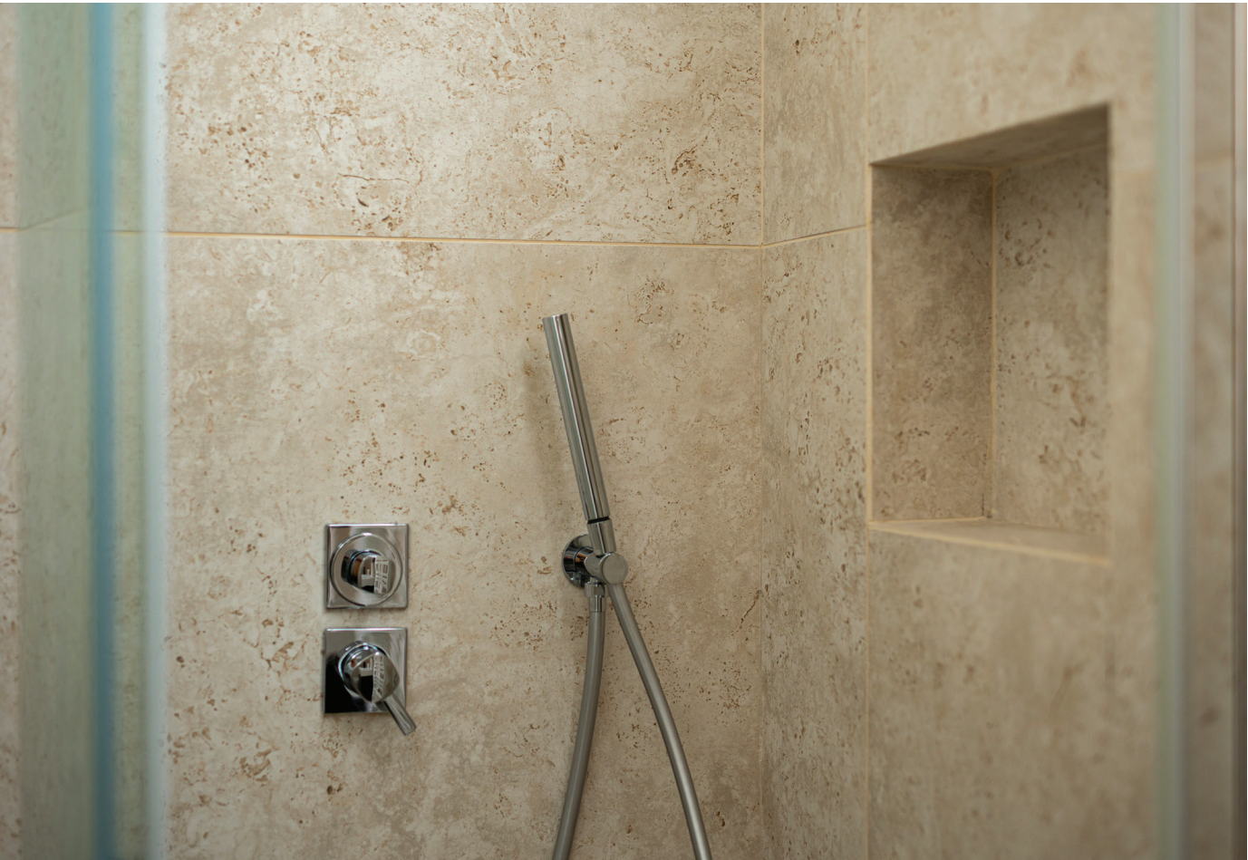
Dettaglio nicchia cabina doccia in Dekton Sabbia
