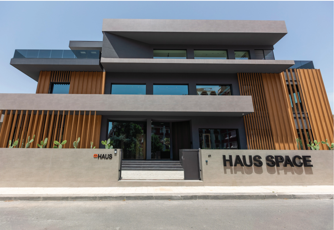
Rivestimento murature e marca piani in grande lastra Dekton Keon e Sirius incollati su Aquapanel®
