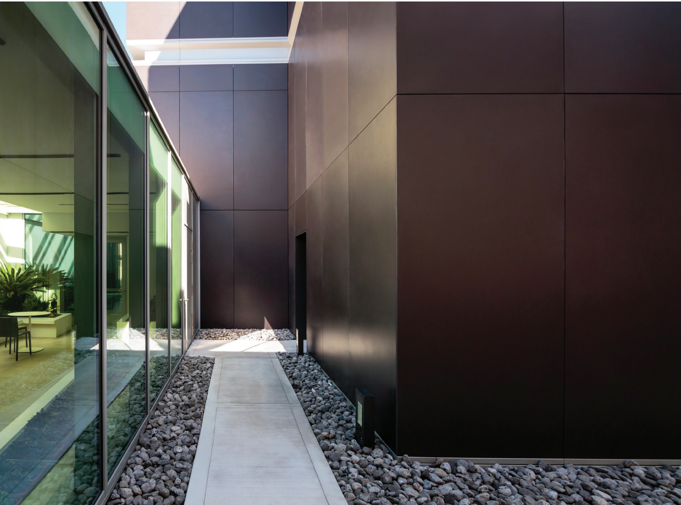
Dettaglio di rivestimenti di facciata uffici in formato 320 x 144 cm. Sistema di fissaggio sottosquadro a scomparsa. Dekton Domoos
