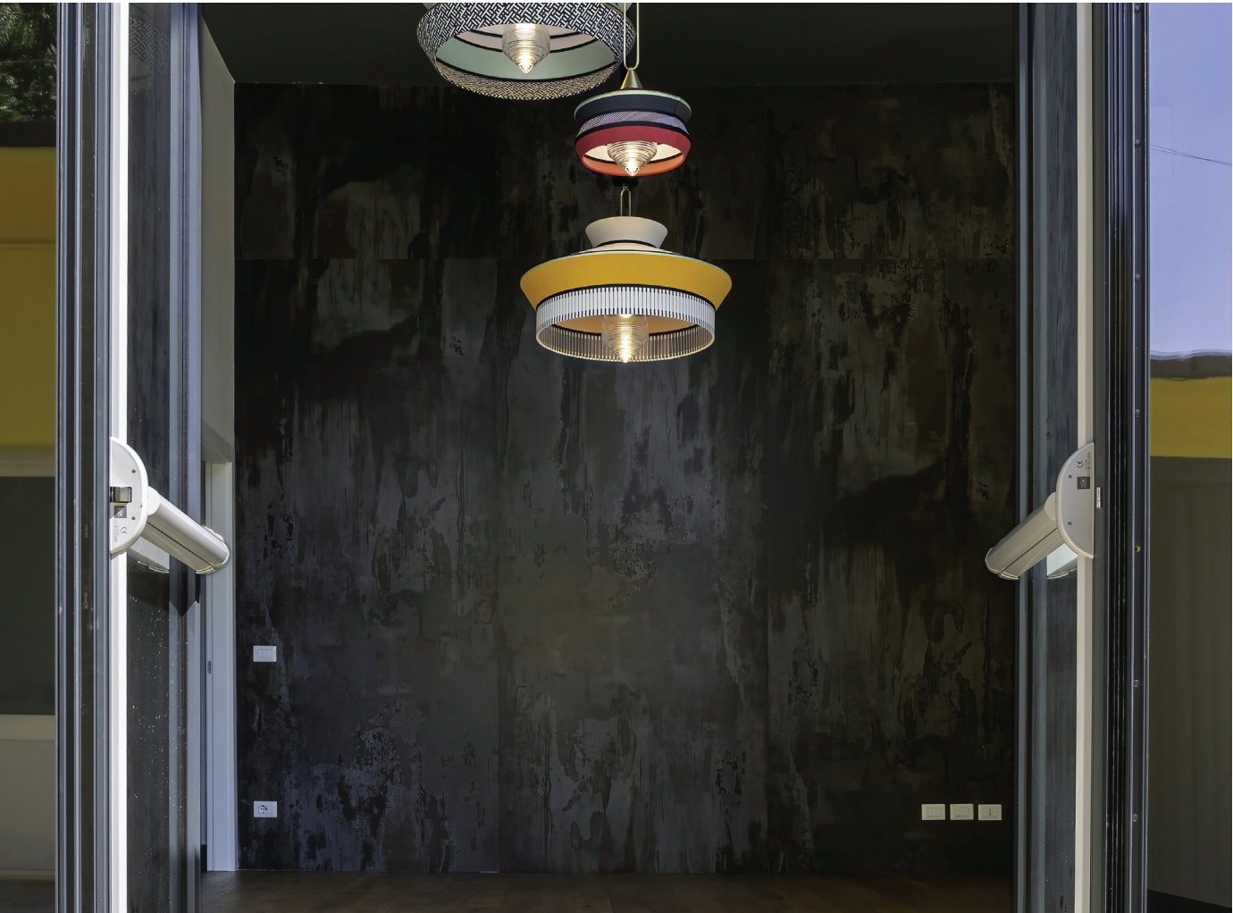
Rivestimento a parete in Dekton Trilium in grande formato
