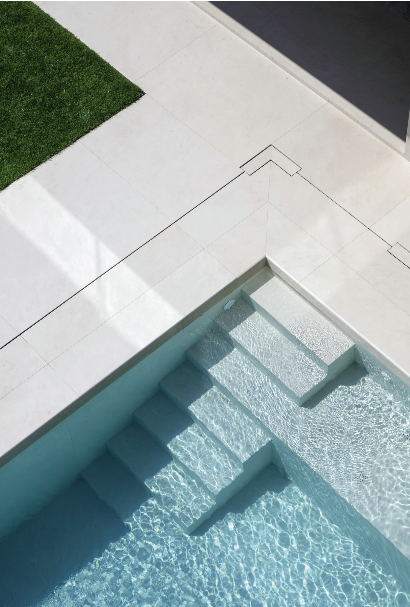
Rivestimento piscina con scala e gradoni. Bordo piscina e pavimentazioni con scarichi lineari e ispezioni. Dekton Nacre in grande formato
