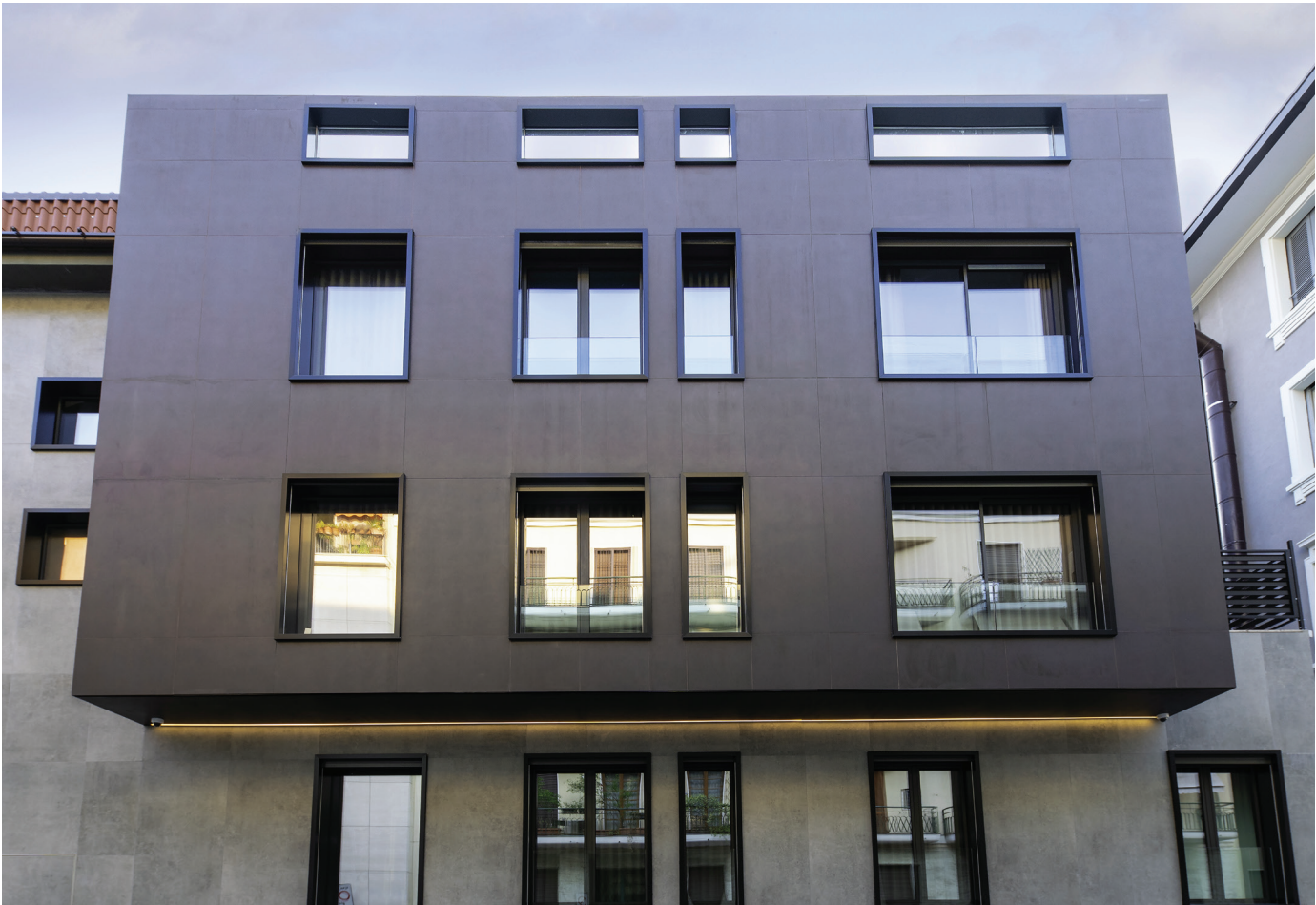
Rivestimenti facciate in grande formato. Dekton Keranium e Kreta, incollati su intonaco strutturale
