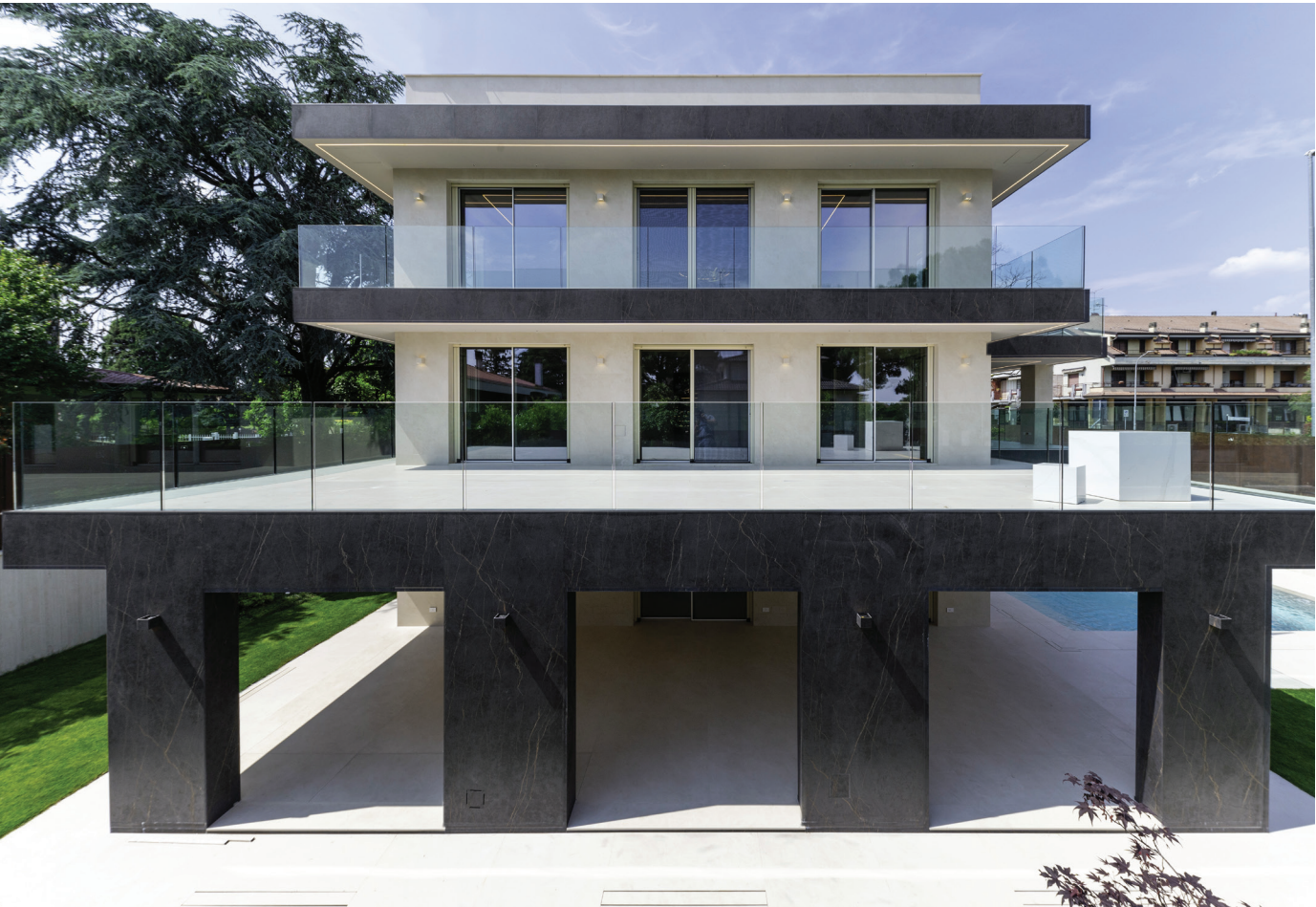
Rivestimenti di facciata, marca piani e porticati in grande formato tagliati a misura, incollati su intonaco strutturale e Aquapanel®. Dekton Laurent e Nacre
