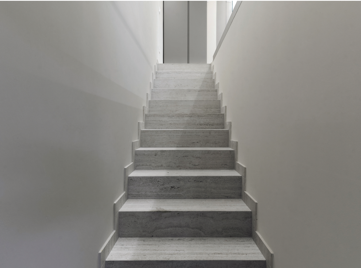
Rivestimento scale in cemento con pedate, alzate e battiscopa in Dekton Marmorio
