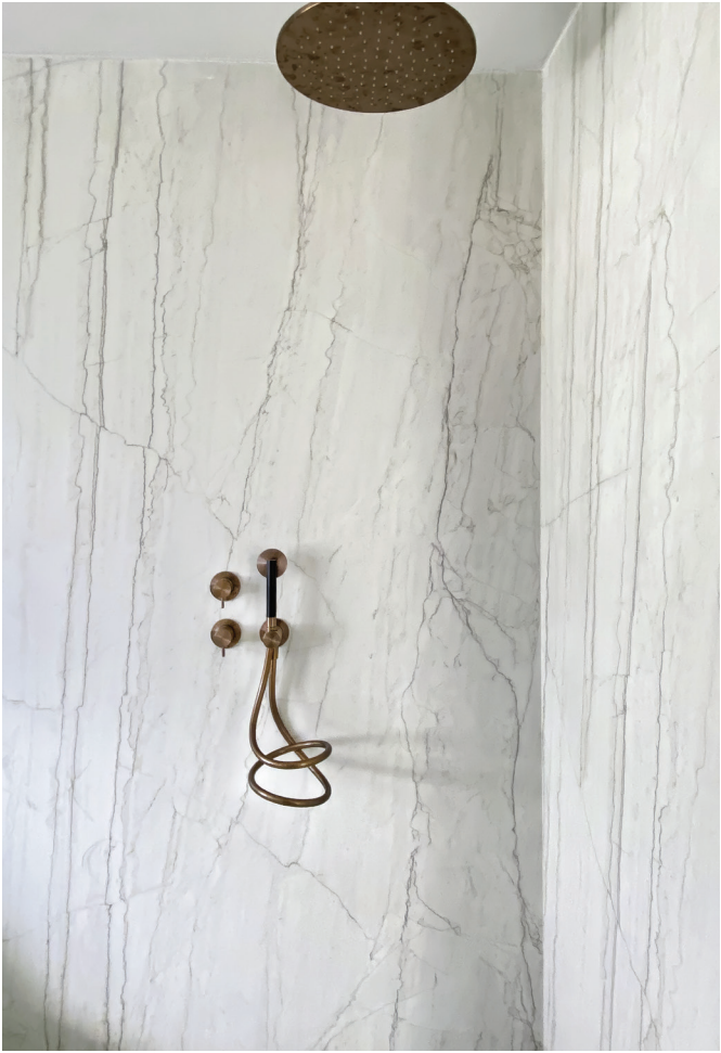
Rivestimento cabina doccia in Dekton Neural
