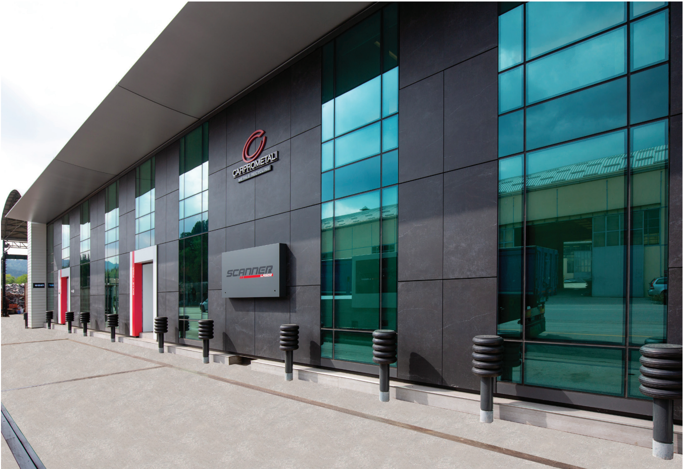
Rivestimento facciata ventilata uffici in grande formato. Sistema di fissaggio sottosquadro a scomparsa. Dekton Laos
