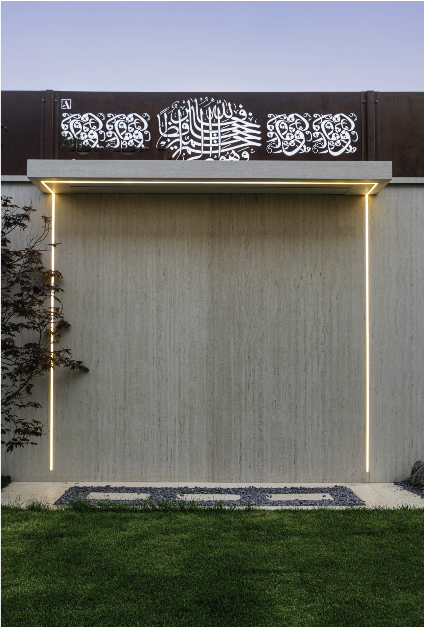
Rivestimento parete outdoor in Dekton Marmorio con funzione di cascata con led strips integrate
