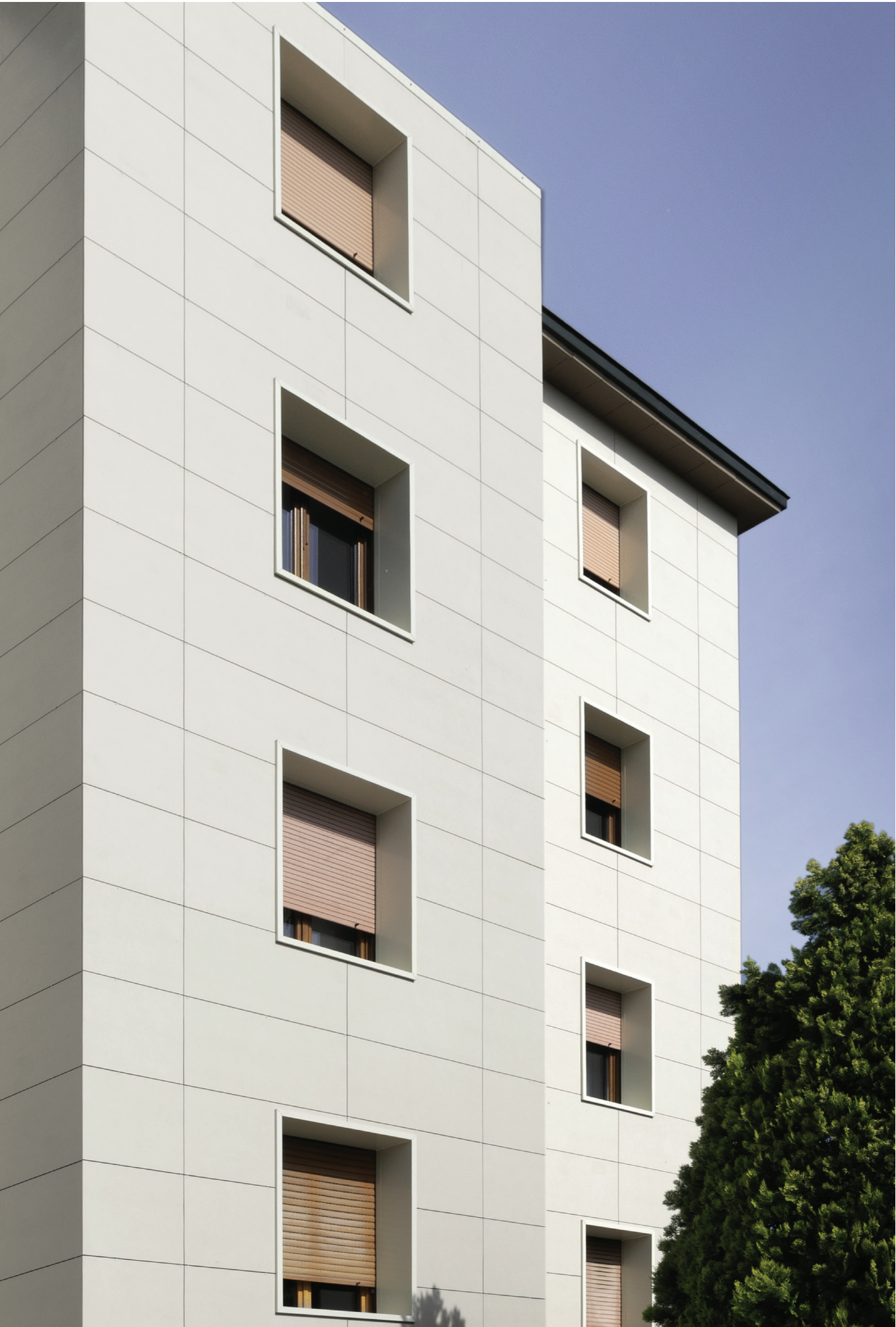
Rivestimento facciata ventilata in grande formato con fissaggi a vista, preverniciato in Dekton Sasea
