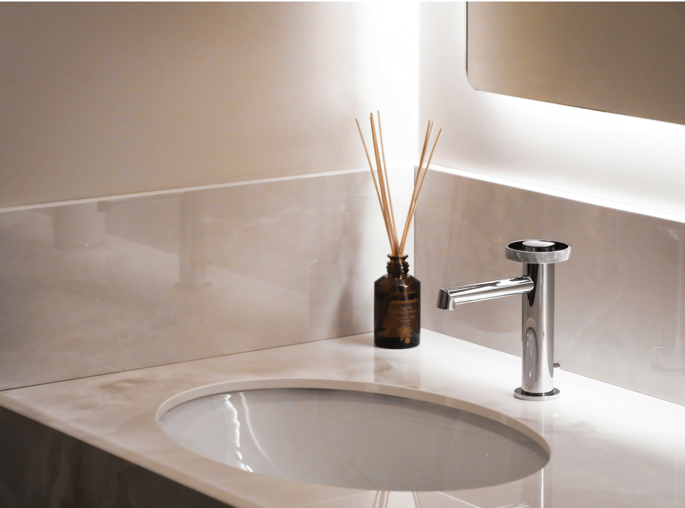
Dettaglio top lavabo con vasca sotto piano e paraschizzi in Dekton Helena
