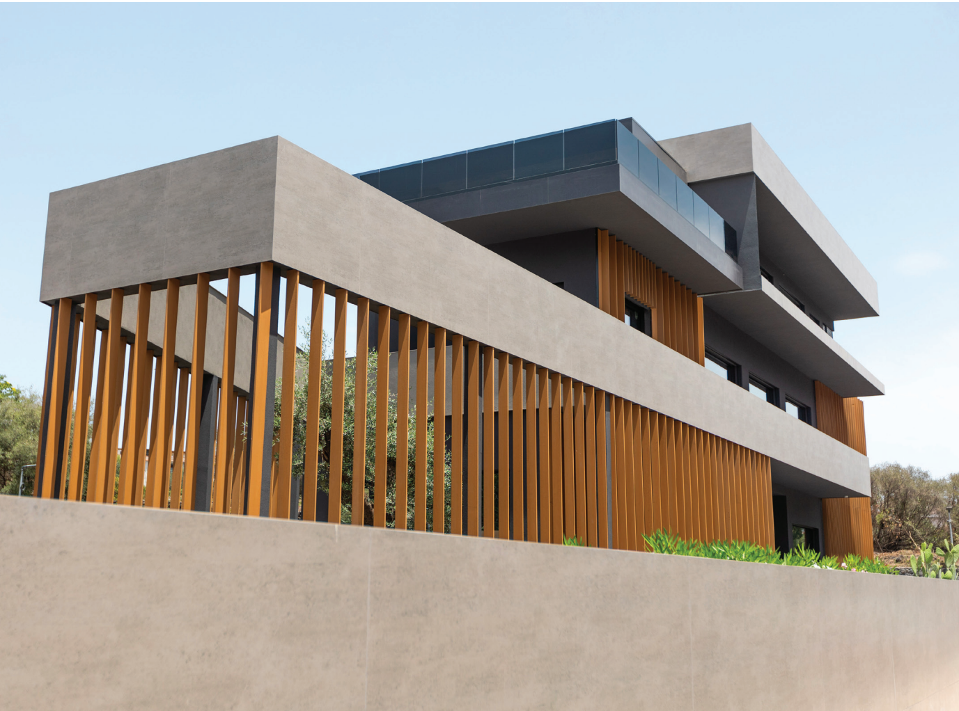
Rivestimento murature e marca piani in grande lastra Dekton Keon e Sirius incollati su Aquapanel®
