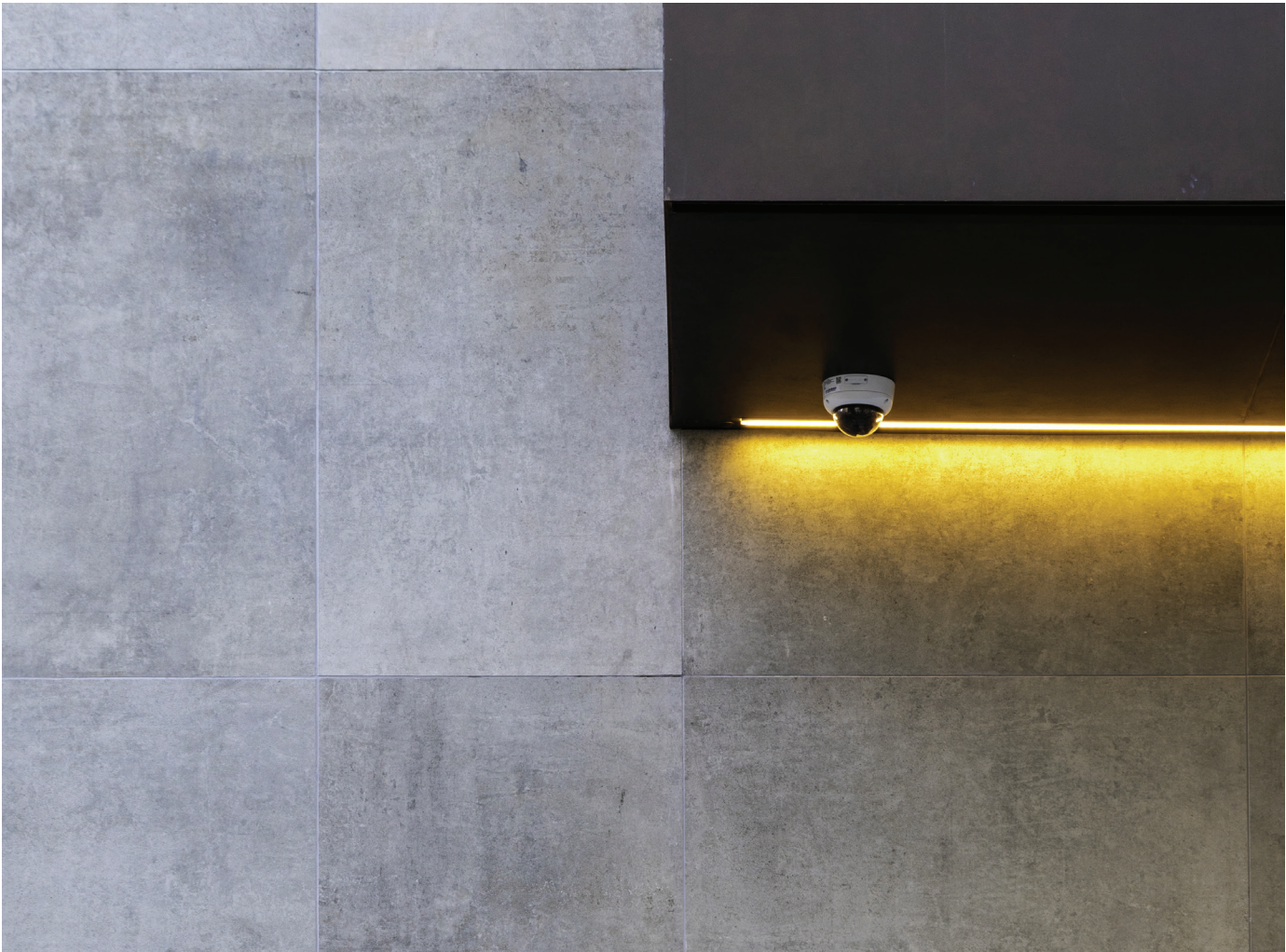
Dettaglio innesto facciate con led strips integrate in Dekton Kreta
