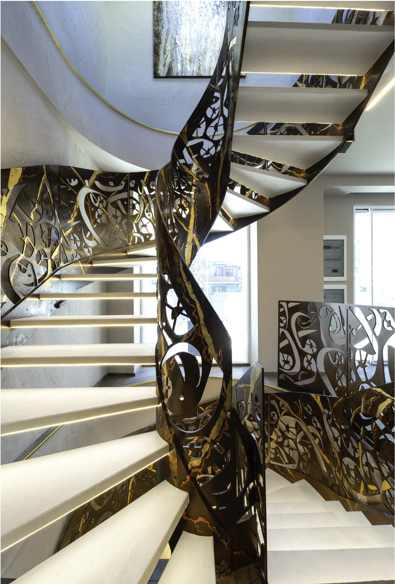
Rivestimento di pedata scala in acciaio sospesa con led strip integrato in Dekton Nacre
