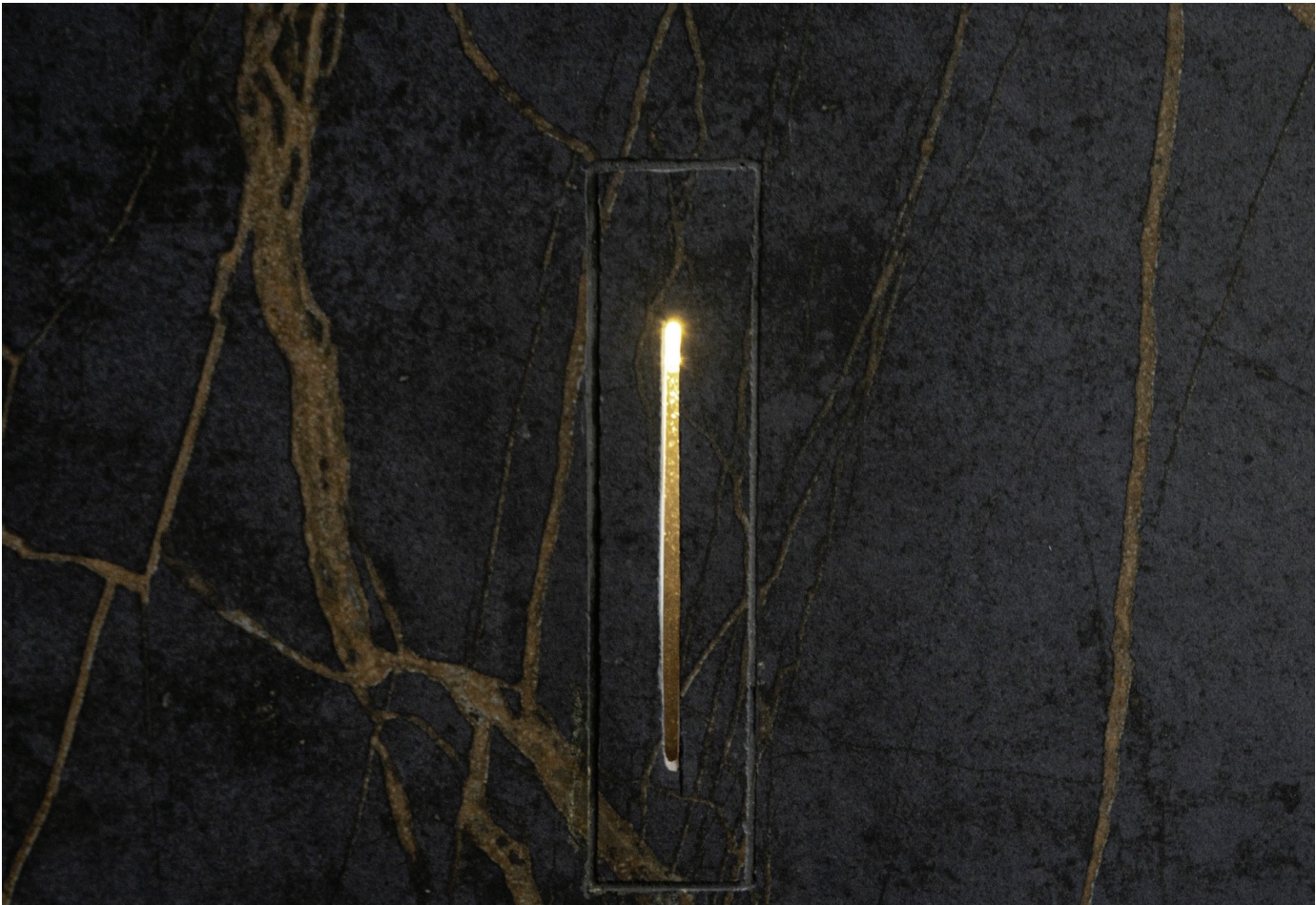
Dettaglio illuminazione led su parete in Dekton Laurent
