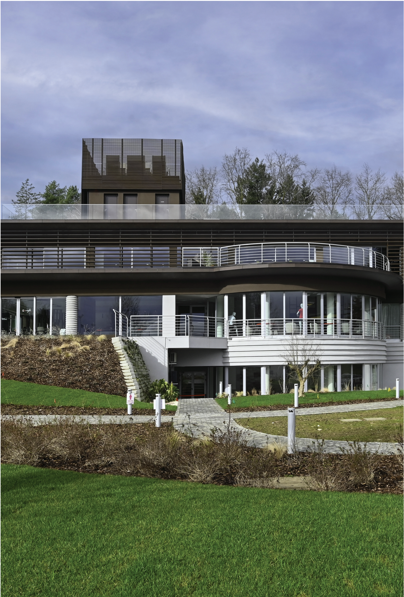
Rivestimento marca piani in aggetto con grandi pannelli. Fissaggio chimico e rivettatura. Dekton ID
