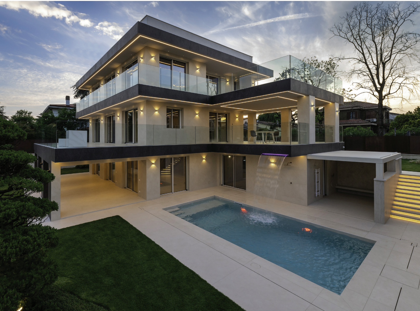
Rivestimenti di facciata, marca piani e porticati in grande formato tagliati a misura, incollati su intonaco strutturale e Aquapanel®. Dekton Laurent e Nacre
