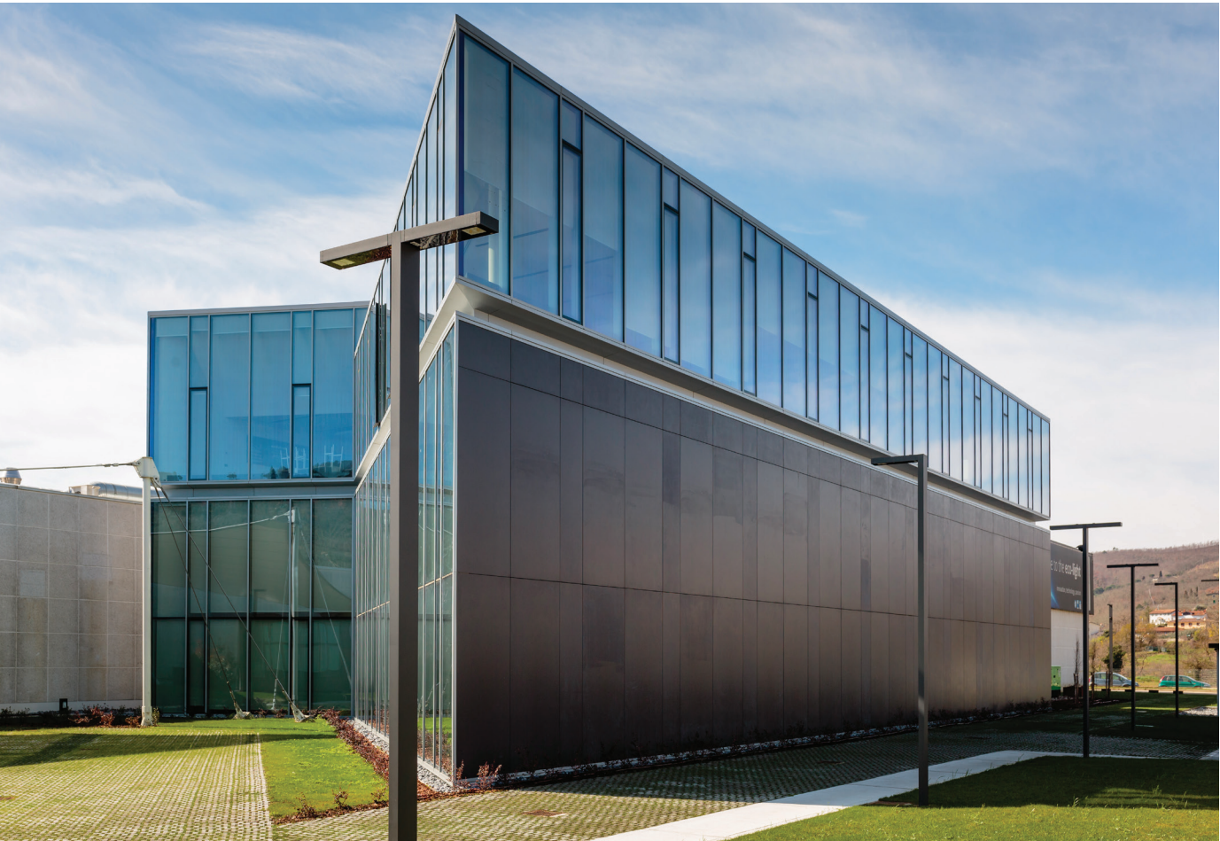
Rivestimenti di facciata ventilata uffici in formato 320 x 144 cm. Sistema di fissaggio sottosquadro a scomparsa. Dekton Domoos
