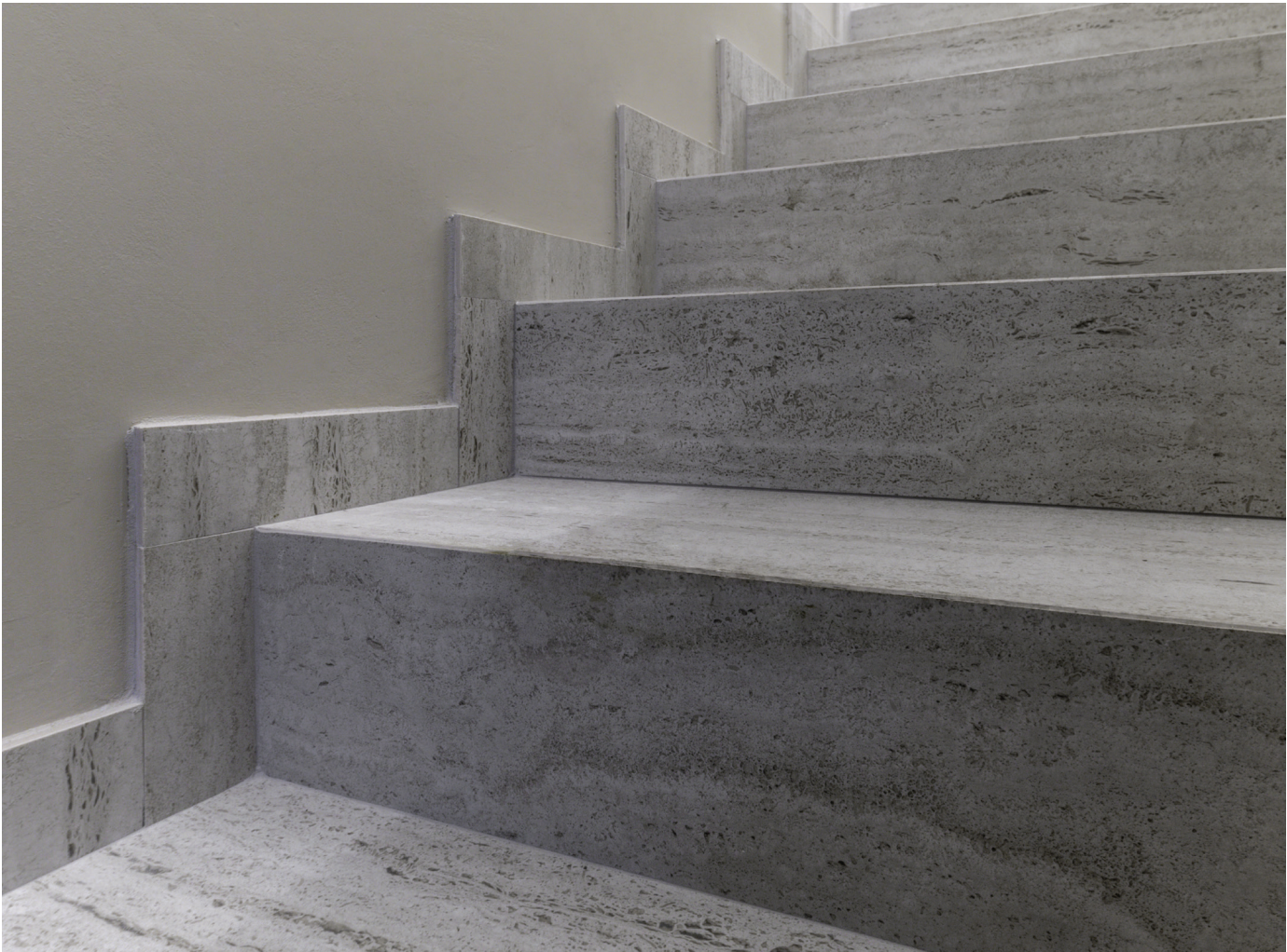
Dettaglio scala in cemento in Dekton Marmorio con spigoli a 45 gradi
