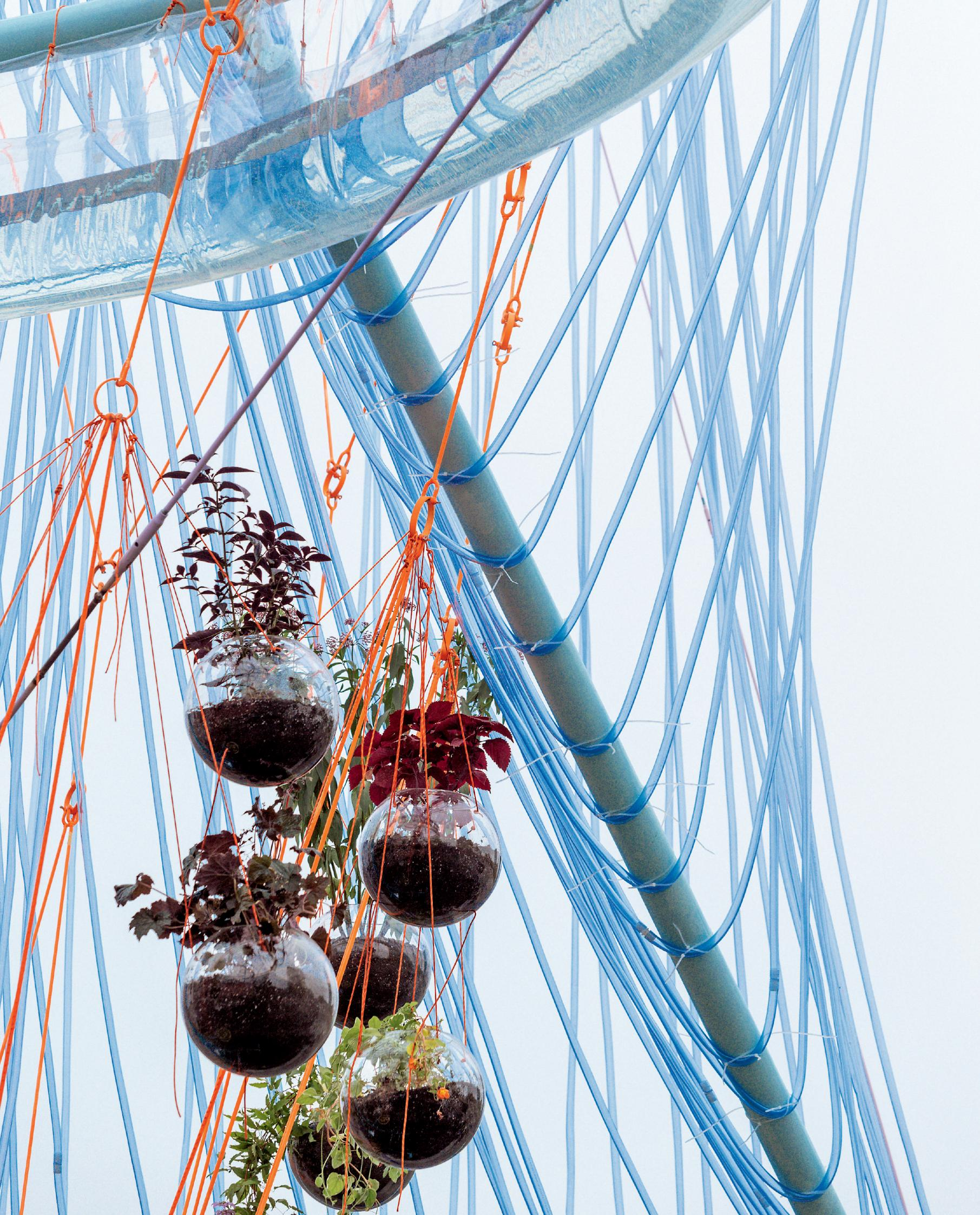
El serpentín de tuberías de plástico estandarizadas forma un circuito que, en fases sucesivas, permite la depuración natural y ecológica del agua; un sensor envía los datos obtenidos a un lector on-line en tiempo real.
