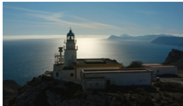
Vista aérea do farol e do Parque Natural Cabo de Gata. Flygbild över fyren och nationalparken Cabo de Gata.
