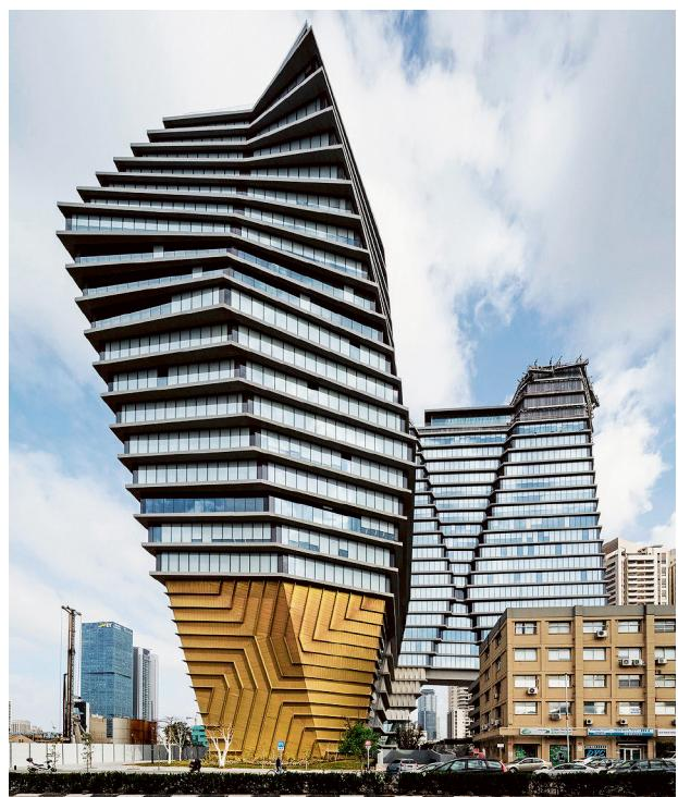
Instalados en forma de X, los paneles Dekton de 320 x 70 cm que componen la fachada ventilada generan una imagen singular de aspecto entrelazado que aporta unidad visual al basamento técnico.
