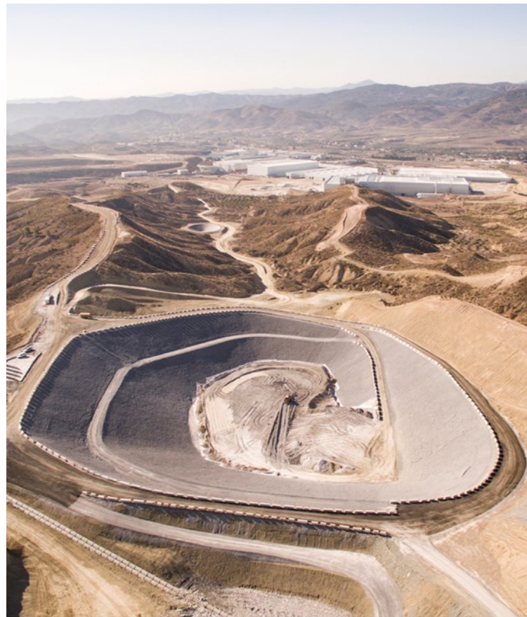
Afvalverwerkings- en terugwinninginstallatie (CoMA)
