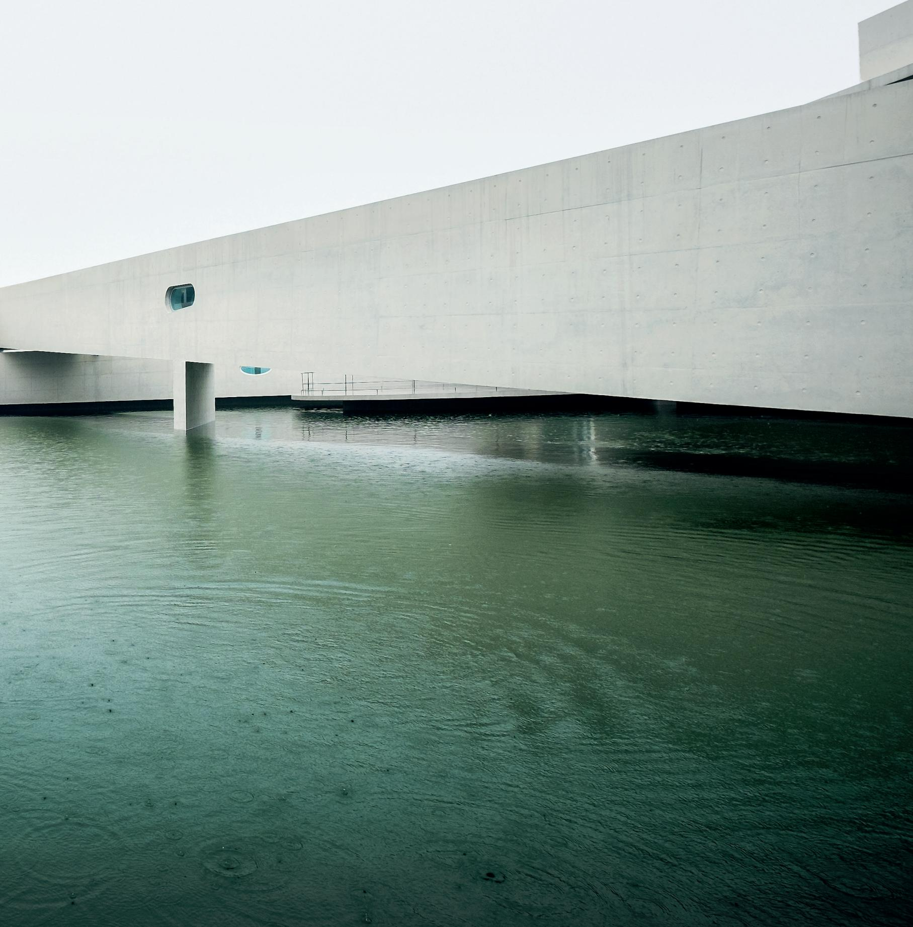
El volumen de oficinas parece flotar sobre el agua del estanque de ocho metros de profundidad, gracias a que los soportes de hormigón se ocultan en una posición alejada del perímetro del edificio.
