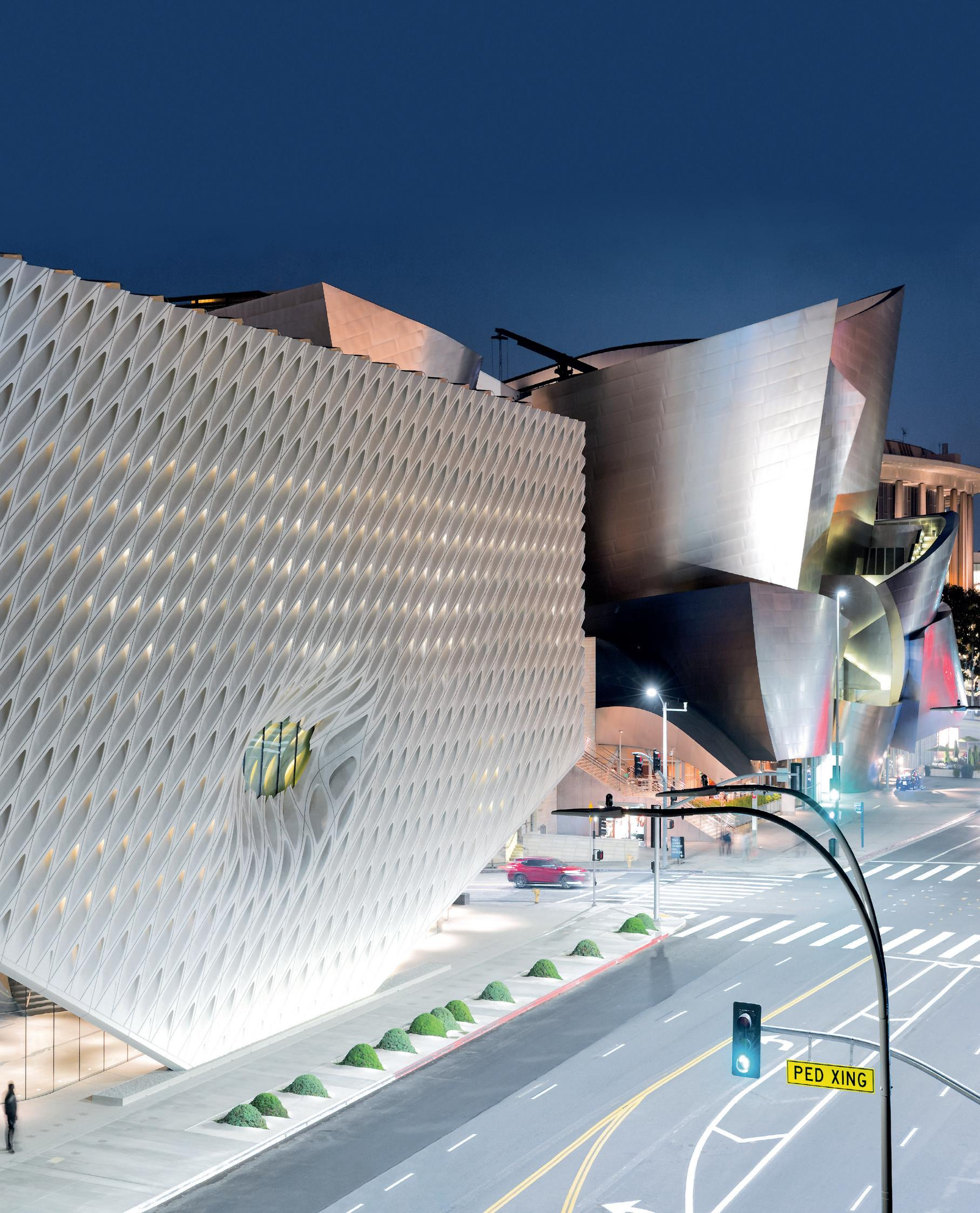
El museo está formado por el 'velo' exterior compuesto de celdillas y por la 'bóveda' con los almacenes, sobre la que se sitúan las salas expositivas conectadas a la planta baja mediante una escalera mecánica.
