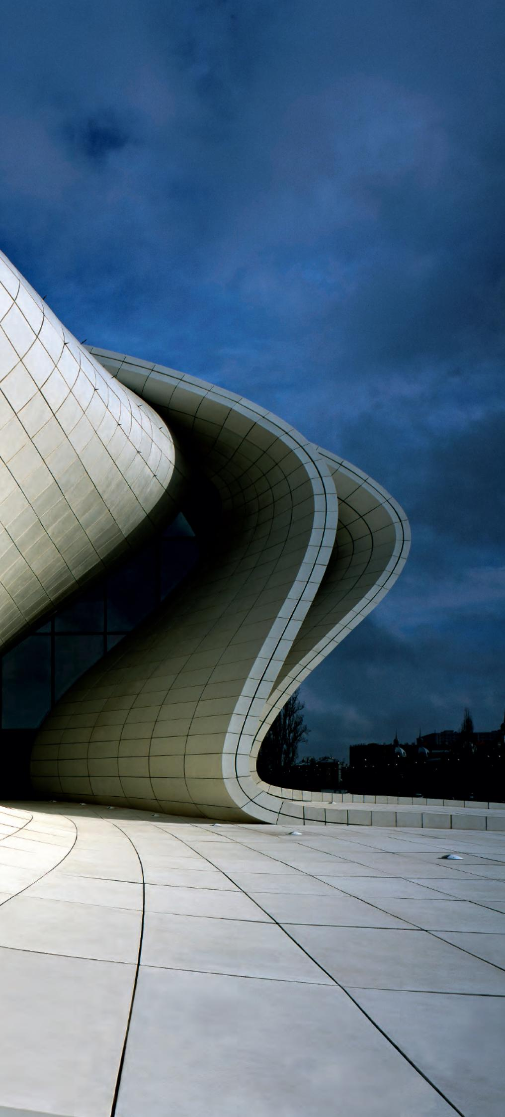
La utilización de avanzadas herramientas informáticas en el diseño y en la construcción hace posible la homogeneidad del revestimiento exterior, de hormigón y poliéster reforzados con fibra de vidrio.
