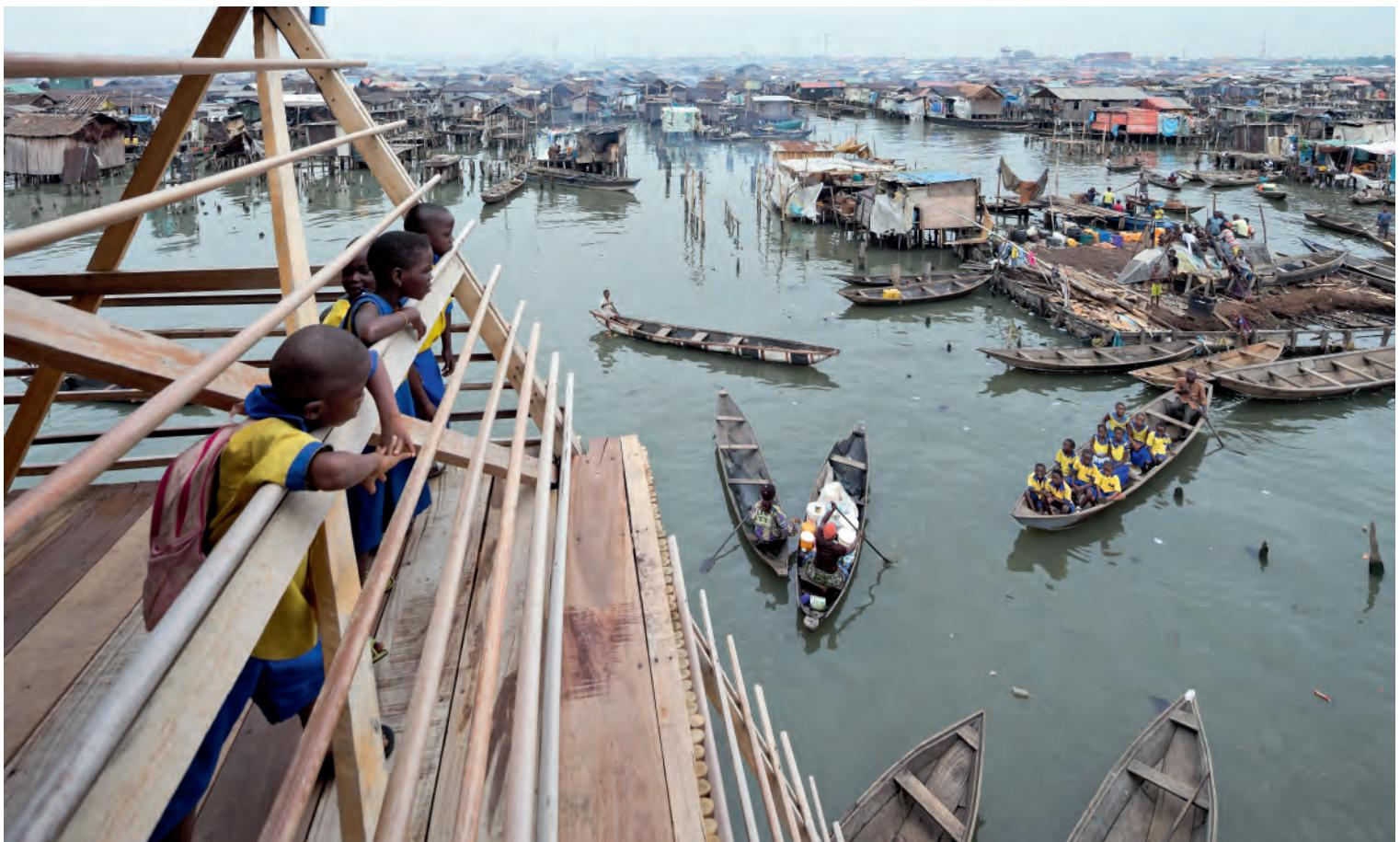
Al flotar sobre el agua, la escuela hace frente a las crecidas. Su estructura está formada por una malla de vigas de madera que se apoyan sobre una base de bidones vacíos de plástico reciclado.
