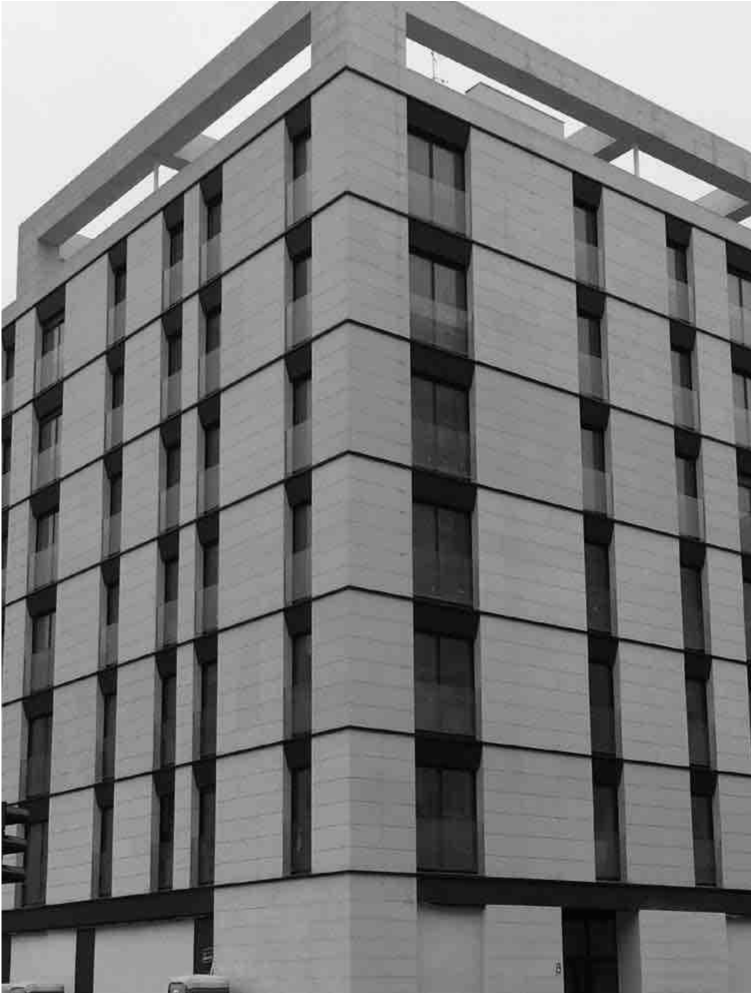
Tabacalera appartementen complex, La Coruña, Spanje
