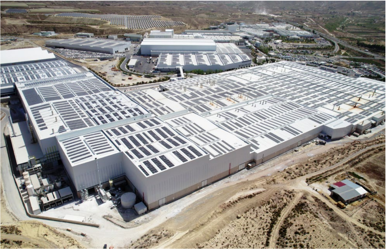
→ Placas solares en la fábrica de Cosentino (Cantoria, Almería)
