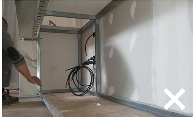
2.M.1. Por un lado, el marco transversal está incompleto (no cierra en el plano del suelo); por otro, falta un marco transversal adicional (el vano supera ampliamente el máximo recomendado y los niveles de apoyo y suelo del chasis no son suficientemente rígidos).
