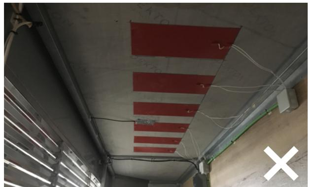
6.M.4. Falta y mala colocación de sonda.
