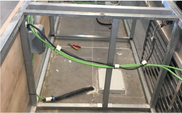
2.2.4. Ejemplo de perfil montante para descargar los esfuerzos debidos a la sujeción de una mampara.
