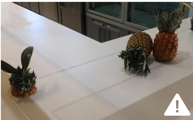
5.A.2. Radios suficientes en esquinas. Rebaje perimetral poco profundo.
