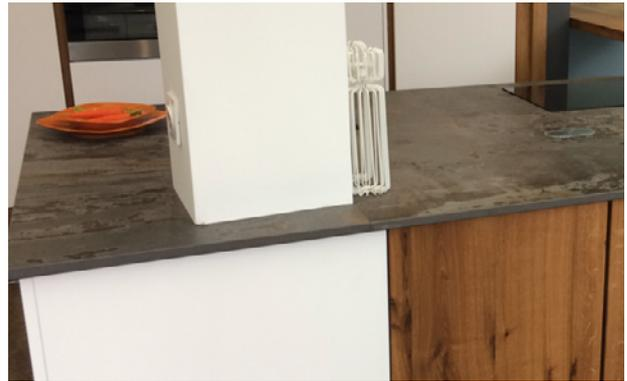
1.4.2. Integración de un pilar en un buffet mediante juntas y pieza en L.
