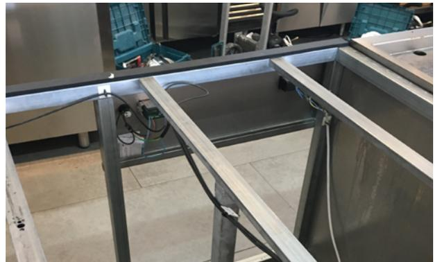
3.1.6. Colocación en toda la superficie de apoyo del nivel superior del chasis.
