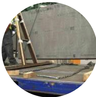
Recolocando una parte del caballete antes de depositar definitivamente la carga (para asegurar su correcto asentamiento).
