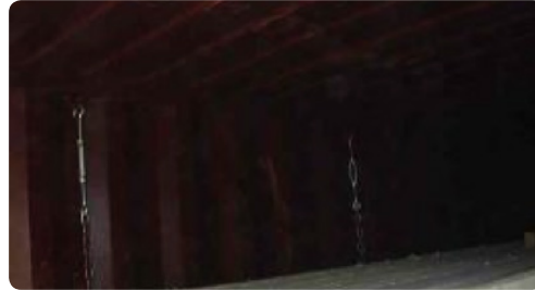
Cadenas enganchadas por los tensores.
