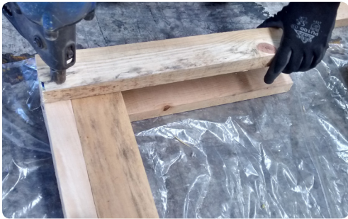
Foto 3: apoyo de las piezas sobre las marcas a 1,30m de distancia
