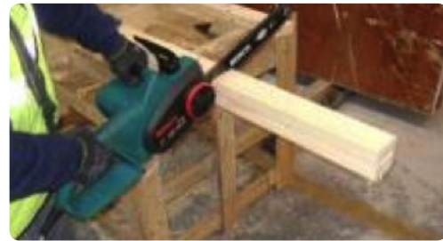
Paso 4: Corte de 4 trozos de madera a medida para fijar los listones entre sí.
