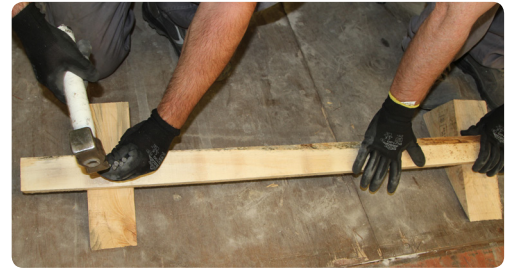
Fabricación de la cuña en el interior del remolque.
