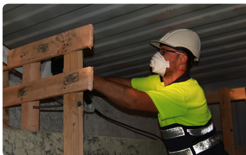
Detalle de la fijación lateral en la segunda fila de carga.
