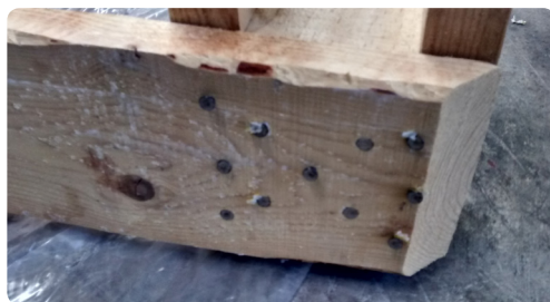
Detalle de la fijación del listón a la base.
