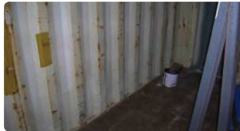
Distancia del caballete al fondo del contenedor: 1,85m o (usando el diseño del contenedor) 7,5 pliegues desde la viga maestra del fondo.
