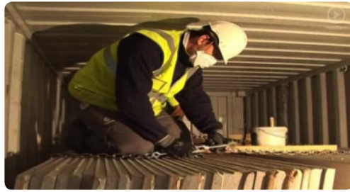
Colocación del mártir de madera bajo el tensor. Se tensan las dos cadenas simultáneamente. Cuando no se pueda tensar más a mano se puede usar una varilla metálica rígida.
