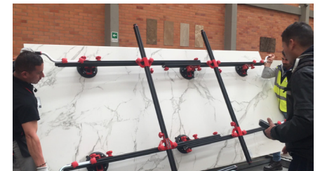
→ Manipulación de baldosas gran formato con ventosas.
