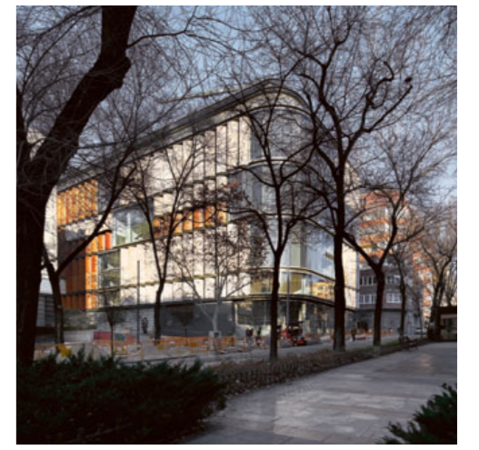
Tanto los solados, aplacados y escaleras de los espacios comunes como los 330 fustes macizos de la fachada —que alcanzan 2.200 kg cada uno— son de Piedra Natural by Cosentino procedente de Almería. The floor surfaces, wall claddings, and stairs of the communal spaces, as well as the 330 solid louvers of the facade — weighing 2.200 kilograms each — are made from Piedra Natural by Cosentino.
