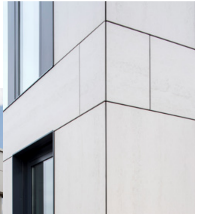
Schittenhelm Büro gebäude. Deutschland.
